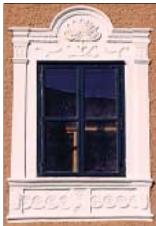
Abb. 3: Hallein, Bürgerhaus, Detail
