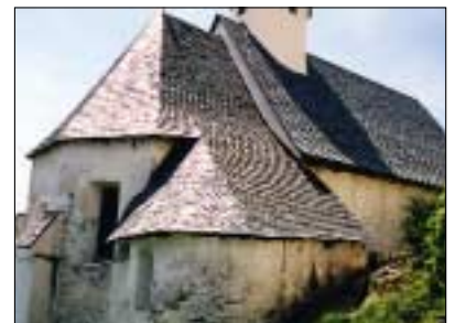
Abb. 5: Sörg, Pfarrkirche hl. Martin, Steinplattldach
