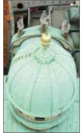
Abb. 4: Graz, Mausoleum, Blick auf die Dachlandschaft
