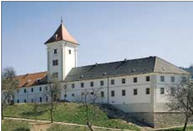
Abb. 5: Waldhausen, ehem. Stift, W-Fassade
