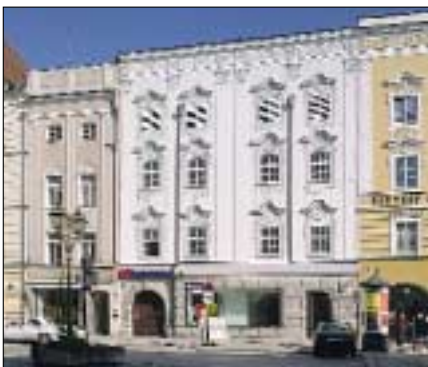
Abb. 6: Wels, Stadtplatz 41, Fassade
