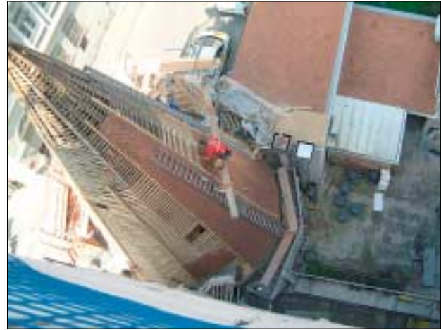
Abb. 3, 4: Krems, Steiner Tor, Dachneudeckung n. R.
