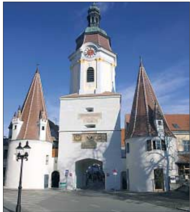
Abb. 3, 4: Krems, Steiner Tor, Dachneudeckung n. R.
