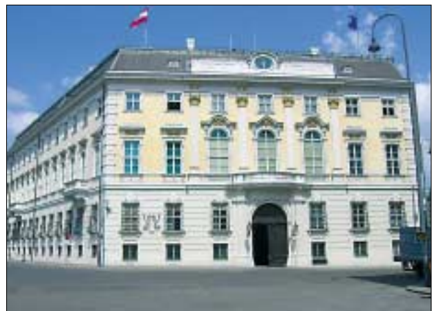
Abb. 3: Wien, Bundeskanzleramt nach Restaurierung
