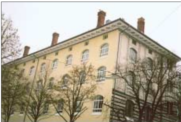
Abb. 1: Wien 16, Heigerleinstraße 74, Schokoladefabrik Julius Meinl
