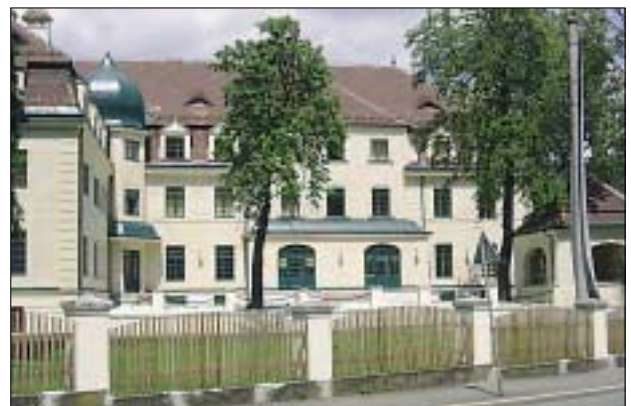
Abb. 3: Werksotel Leoben-Donawitz, ehem. Gästetrakt
