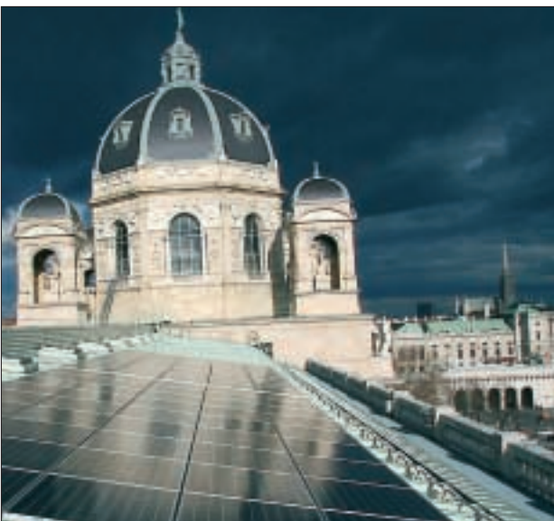
Die 2006 auf 300 m 2 erweiterte Photovoltaik auf dem Südostdach
