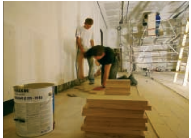
Ausbau der „Jeanne & Donald Kahn Galleries“
